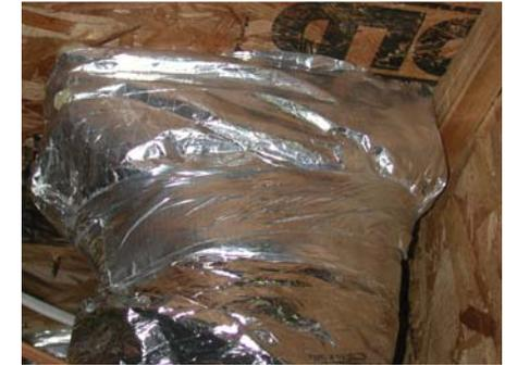
**6** Seal Seams Of Boot / Selle las uniones del adaptador por dentro
