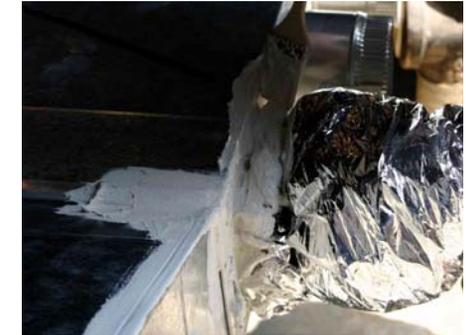
**6** Seal All Seams In Plenum With Mastic / Selle todas las uniones en el plenum con masilla
